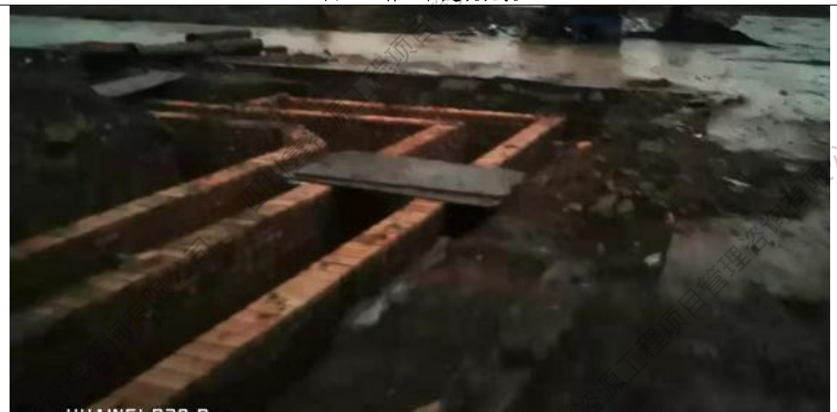
图 2 排水系统沟槽开挖现状
