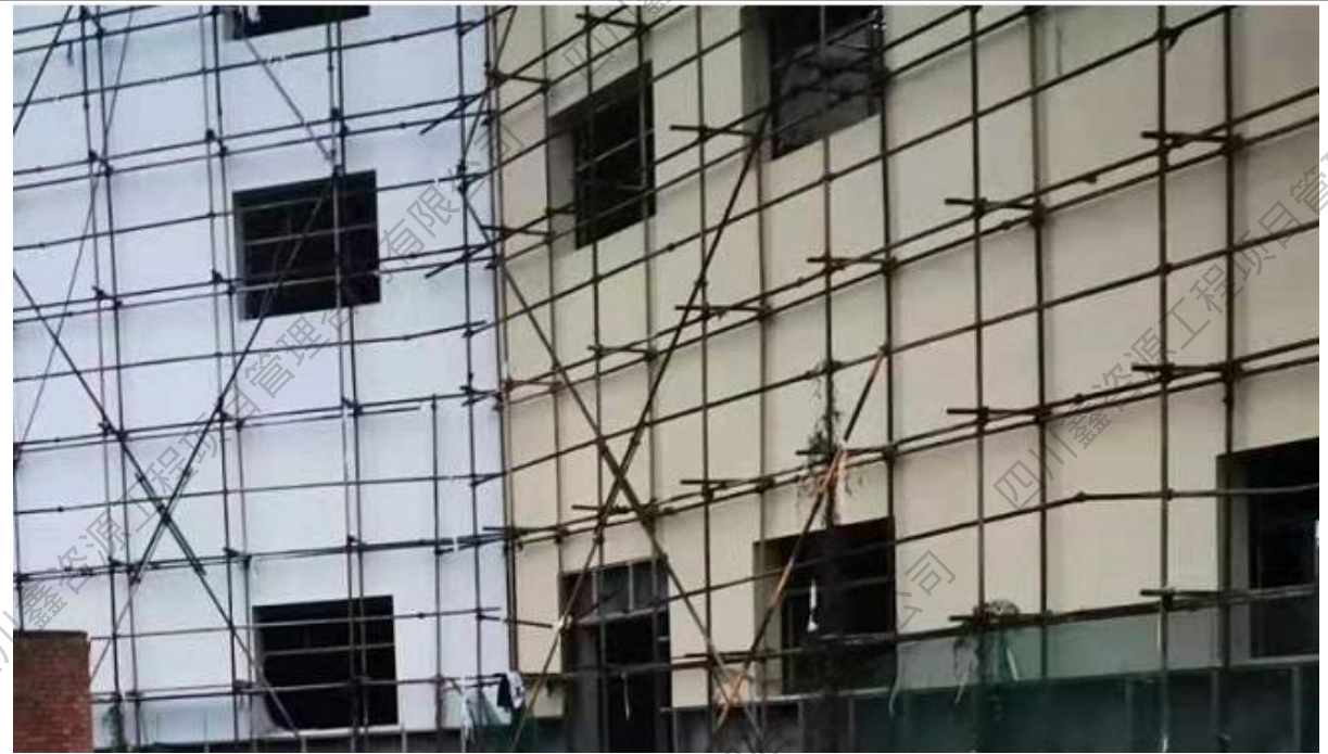
图 1 主体工程建设现状
