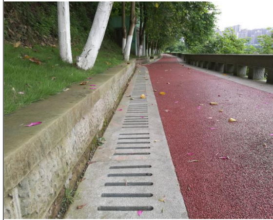
透水铺装+排水沟
