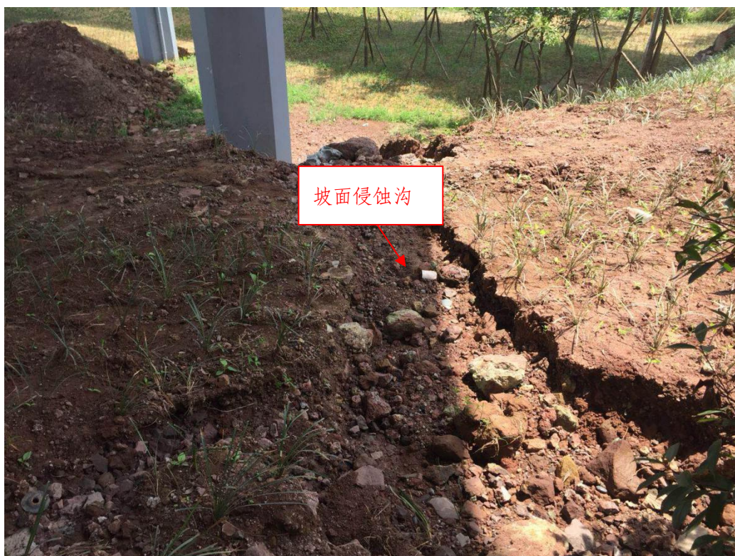
图 2-4 项目水土流失侵蚀坡面
