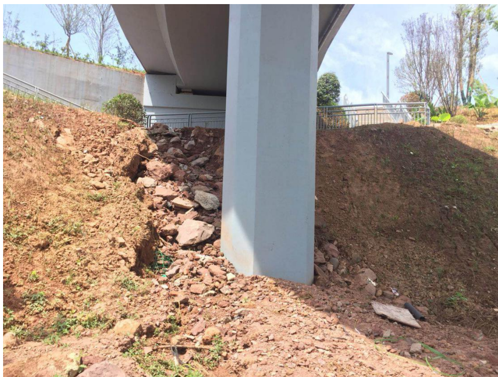
图 5-1 裸露面侵蚀
