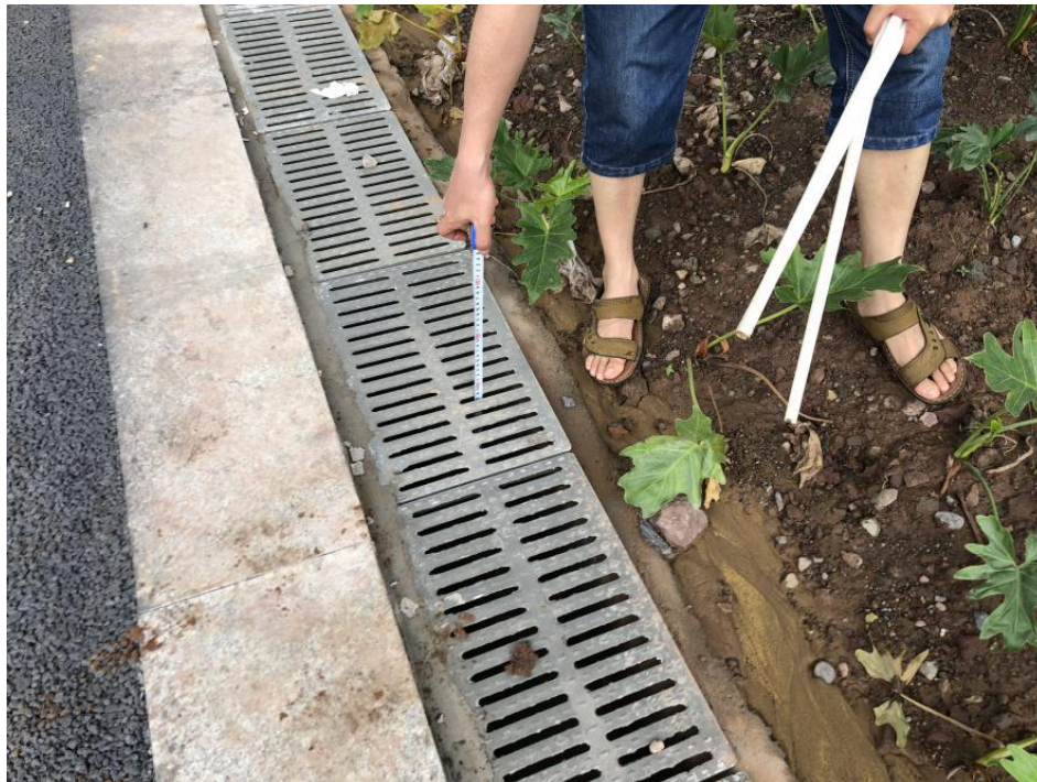
图 2-2 排水沟措施调查
