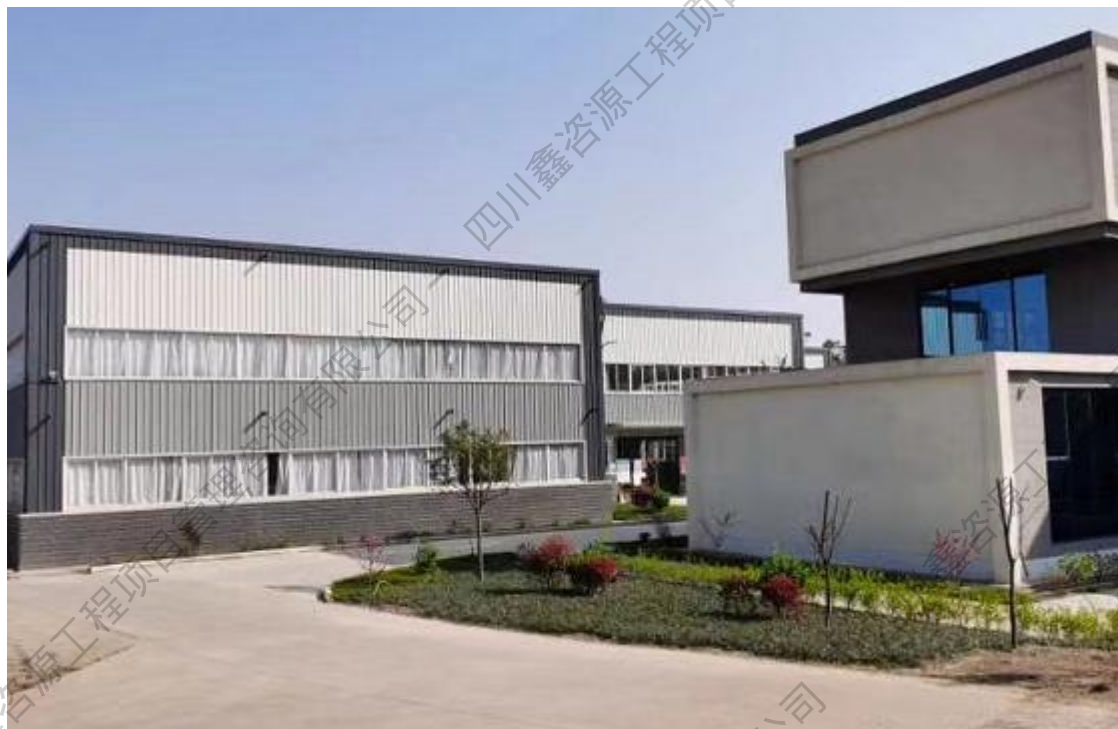
图 1.1-1 主体工程建设现状
