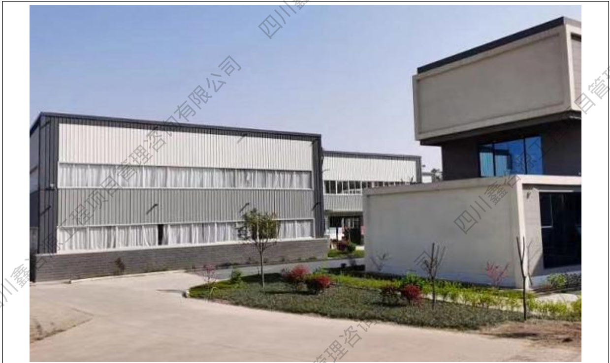
图 1 主体工程建设现状
