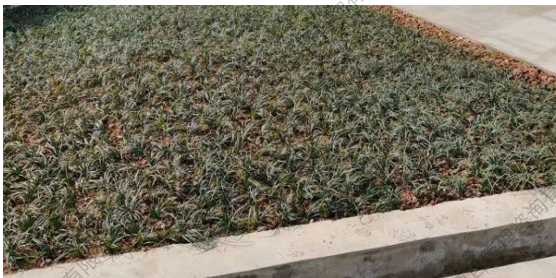
图 1.1-2 雨水沟措施现状
