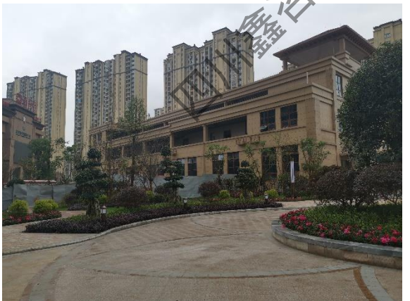
广场路面硬化
